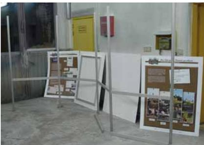
Befestigen Sie jeweils eine weitere Zarge und den nächsten Ständer bis die Grundkonstruktion steht.
