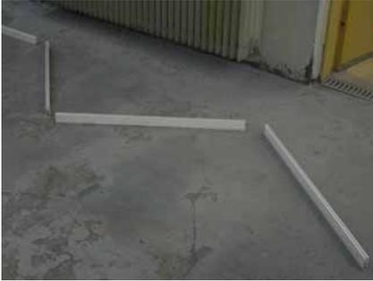
Legen Sie eine (doppelte) Reihe Zargen in der gedachten gewinkelten Abfolge (135° oder 90°) auf den Fußboden aus.
