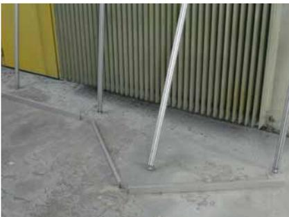
An jedem Knick- und Eckpunkt steht ein Ständer, in den unten ein Fuß eingesteckt wird.
